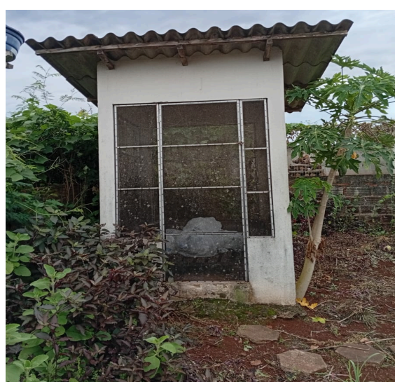
Imagem 34: local de armazenamento de RSS
