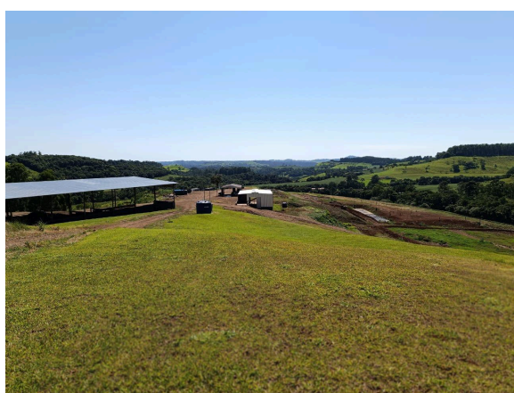
Imagem 23: instalações do aterro sanitário em Nova Esperança do Iguaçu
